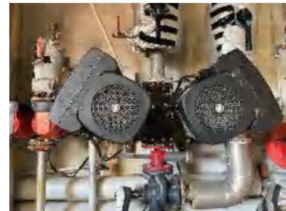
Exemple de circulateur à débit variable
