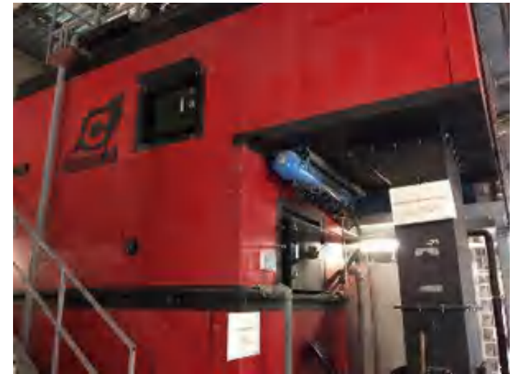
Chaudière à bois du CH de Gap : environ 80% des besoins par le bois et 20% par les chaudières gaz d'appoints.
